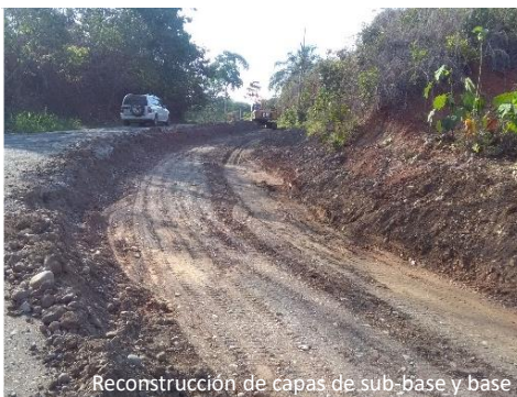
Bacheo formal previo a colocación de carpeta
