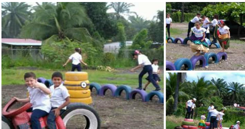
Construcción de un parque de llantas en la escuela de los Sueños.
