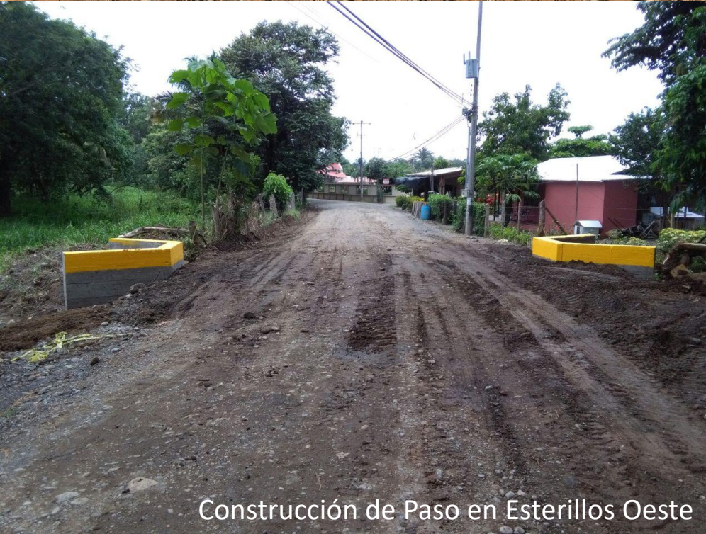
Construcción de cabezales en el Tigre
